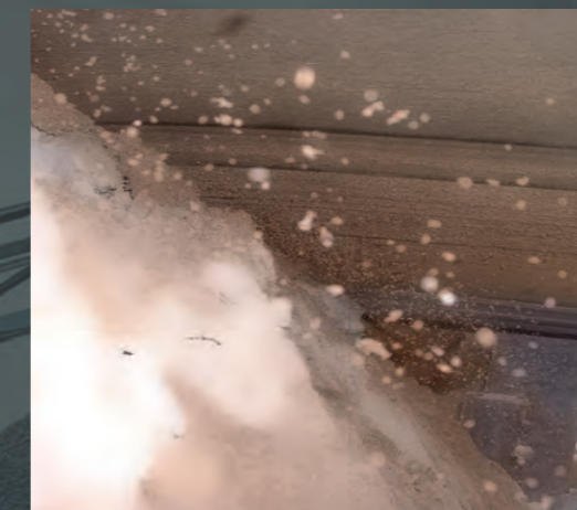
Bande transporteuse nettoyée de manière insuffisante
