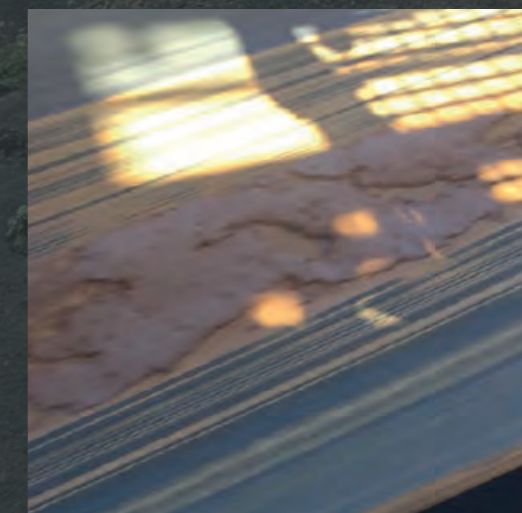
Matériau adhérent à la bande transporteuse
