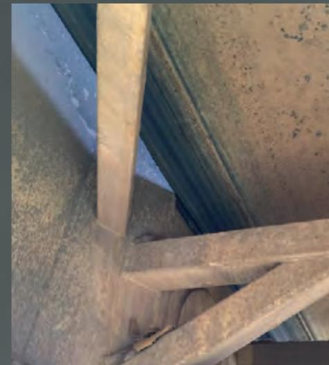
**Gurtschieflauf:** Fördergurt schneidet bereits in die Tragkonstruktion
